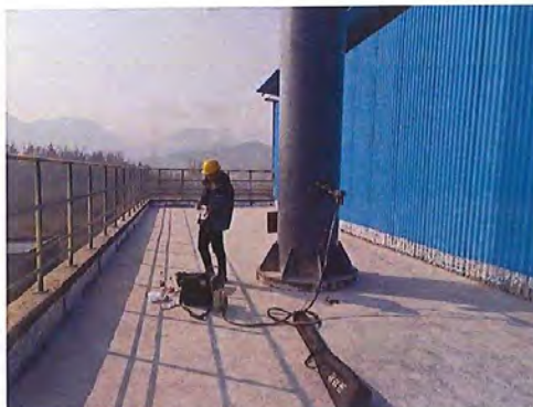
原料尾气排放口 1 (◎DA014)
